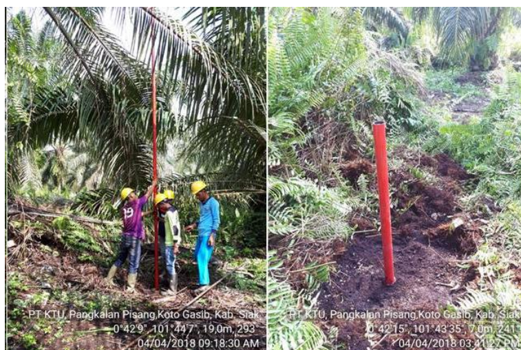
Gambar 9. Pemasangan tiang subsidensi (kiri) dan tiang subsidensi yang sudah terpasang (kanan). Tiang ini digunakan untuk memonitor laju penurunan (subsidensi) permukaan gambut.
