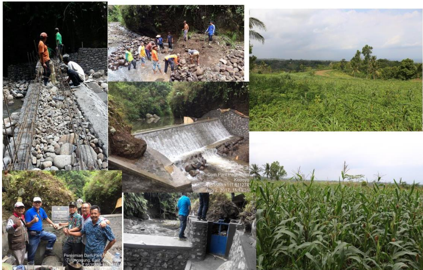
Gambar 3. Pembangunan dan pemanfaatan dam parit untuk irigasi
