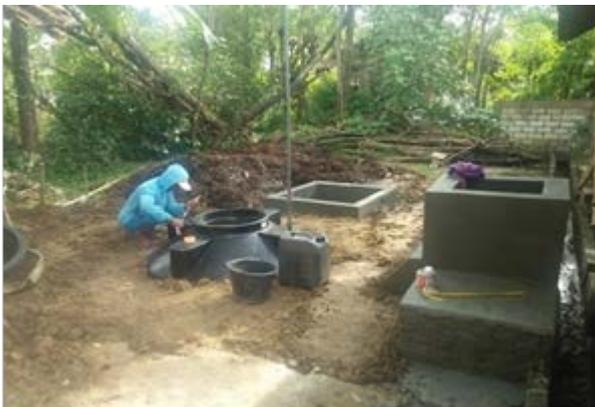
Gambar 5.72. Pembuatan Biodigester skala rumah tangga di Desa Sidomukto
