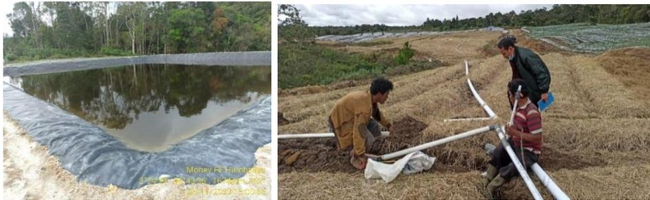
Gambar 33. Pembuatan Embung dan Penataan Saluran Pipa Saluran Irigasi Di Area 15 Ha Kegiatan Food Estate Humbang Hasudutan Sumatera Utara
