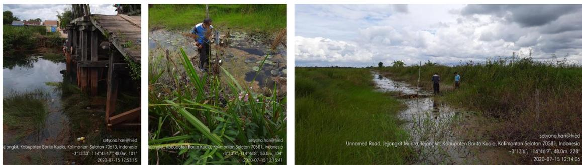
Gambar 26. Pemeliharaan Instrumen Perekam Data dan Koleksi Data Hidrodinamika di Demfarm Jejangkit, Kalimantan Selatan
