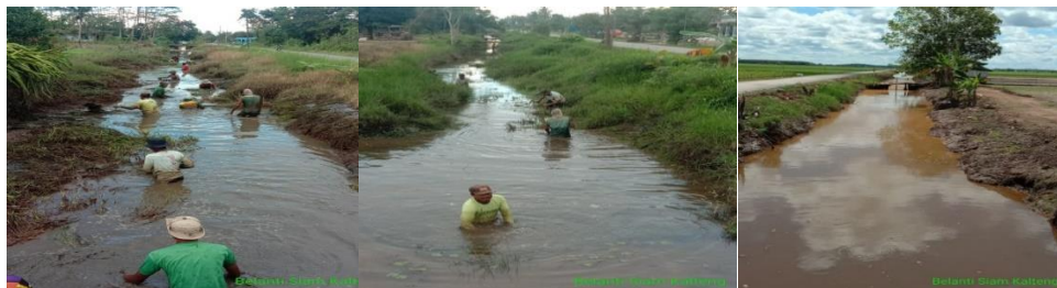
Gambar 59. Pembersihan saluran tersier
