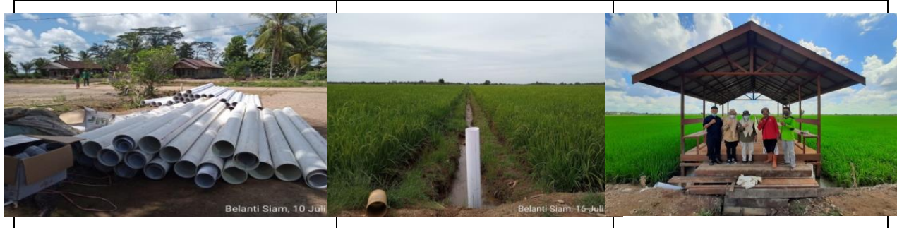
Gambar 60. Perbaikan pintu-pintu saluran dan pembenahan prasarana lainnya
