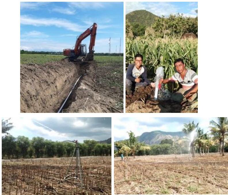
Gambar 17. Tahapan kegiatan implementasi dilakukan dengan: (a) Penggalan saluran pipa irigasi menggunakan excavator (kiri atas), (b) Outlet irigasi untuk koneksi selang big gun sprinkler , (c) Sistem penyiraman jagung pada lahan menggunakan big gun sprinkler .
